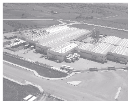
Stabilimento di produzione finestre San Basilio - Mottola (Ta) L'impianto fotovoltaico produce l'intero fabbisogno energetico della produzione pari a 1.348.000 kWh/anno.
